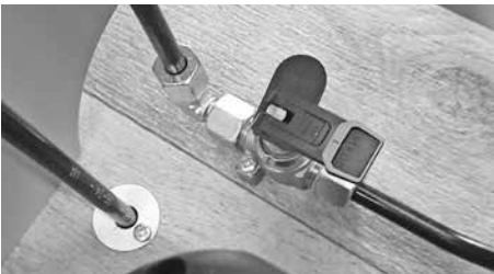
Absperrhahn Heizung
